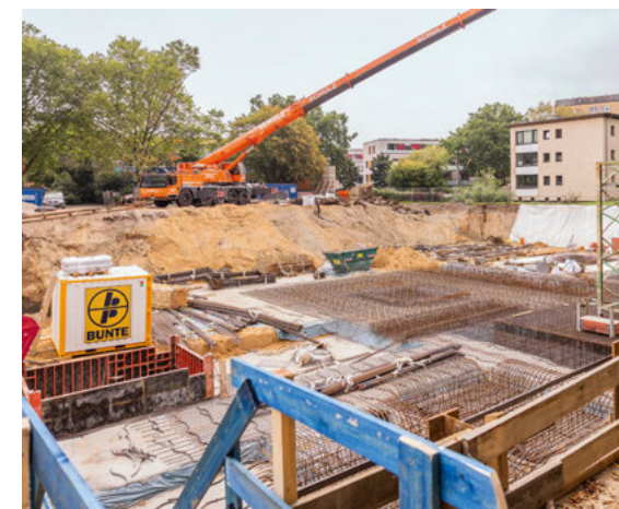
LOK67: Auch auf Baufeld B geht es sichtlich voran.
