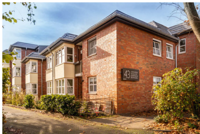
Wiederaufbau: Nach dem Brand in der JAGSt nutzte die KAIFU die Baumaßnahmen für eine umfassende Modernisierung.
